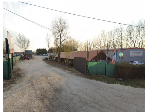
2. fotó – A területet keletről határoló raktárépületek
