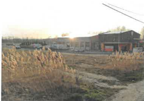
1. fotó – A területet keletről határoló raktárépületek
