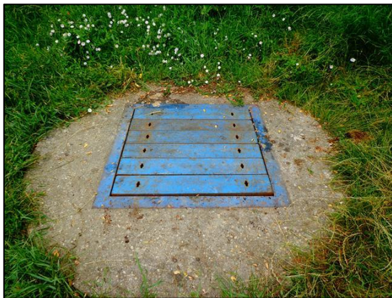
Átemelő akna lefedése
