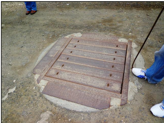
Átemelő akna lefedése
