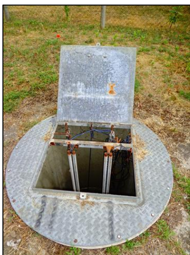
Átemelő akna lefedése
