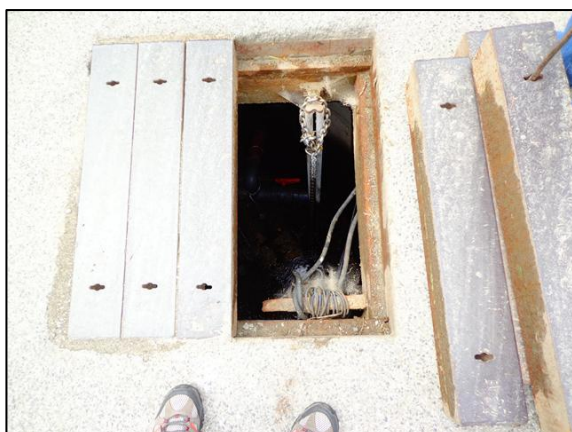
Átemelő akna lefedése
