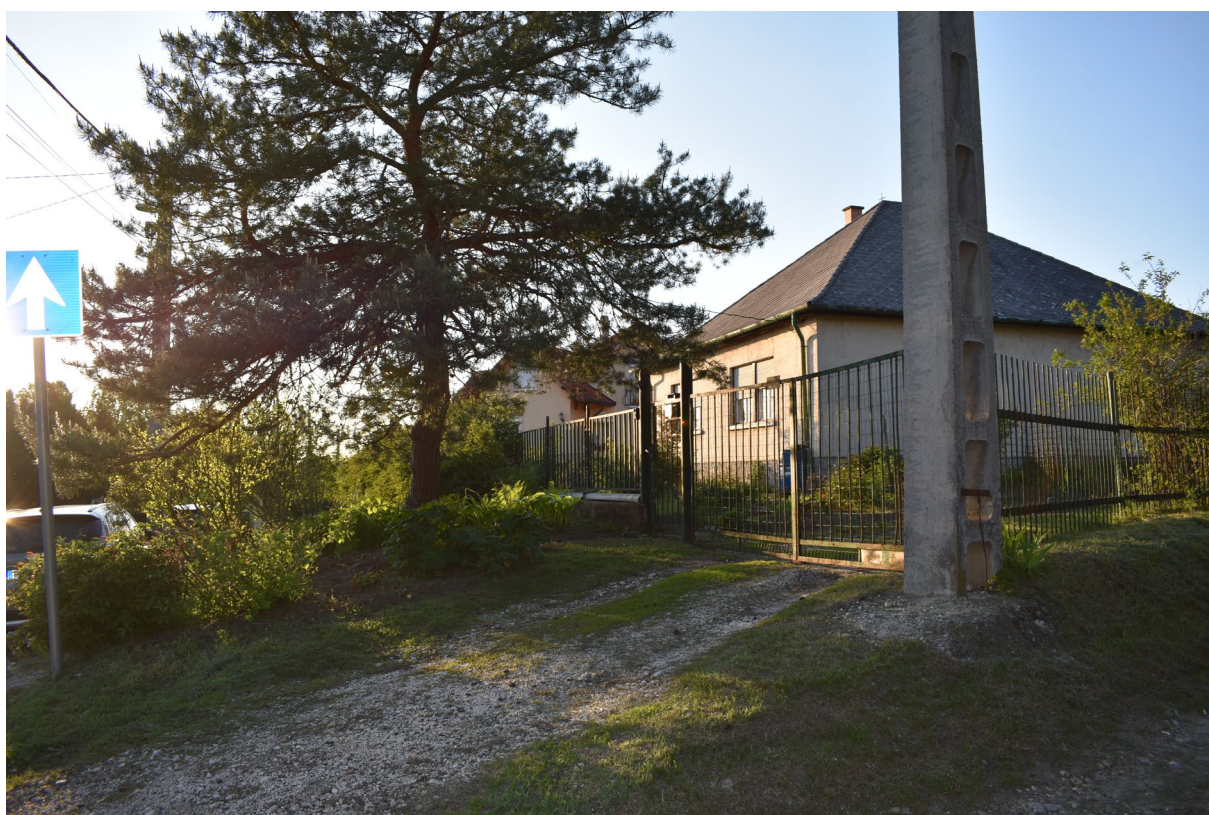
12. ábra – Lakóház a 755/13 hrsz.-ú telken (saját fotó)
