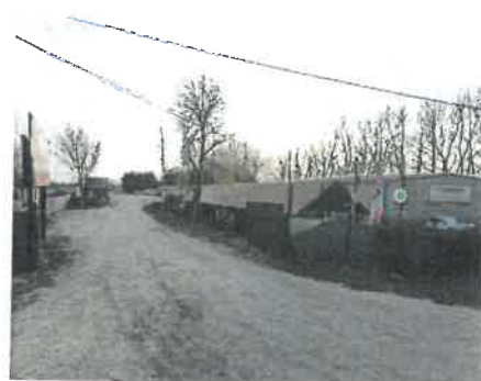
2. fotó – A területet keletről határoló raktárépületek
