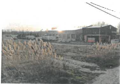
1. fotó – A területet keletről határoló raktárépületek
