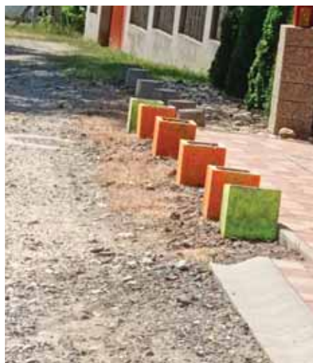
Színesre festett betonkocka elhelyezése balesetveszélyes
