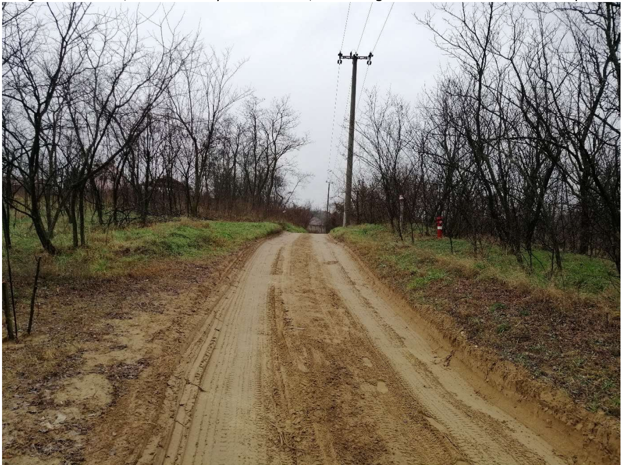
Margita utca a 4571/2 hrsz. előtt, a Csatári u. felé nézve, a tűzcsappal és a betonoszlopokkal
