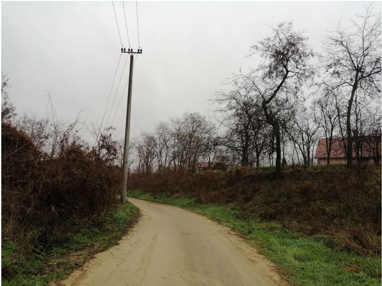
Margita utca a 4571/1 hrsz. keskeny szakasza előtt, a 20 kV légvezetékekkel és annak betonoszlopával
